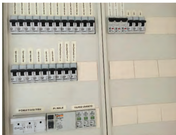
Áramtalanító kismegszakítók
